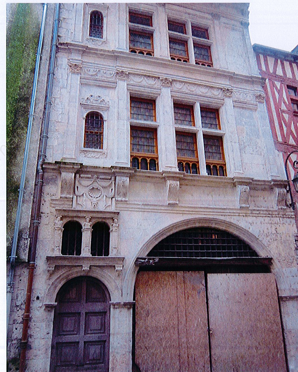
Photographie de la façade en cours de restauration.
